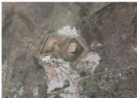
Рисунок 7 – Территория вблизи полигона ТКО до проведения работ по ликвидации несанкционированной свалки
