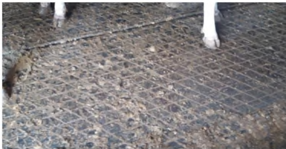
Рисунок 1 – Нарезанные бетонные покрытия
